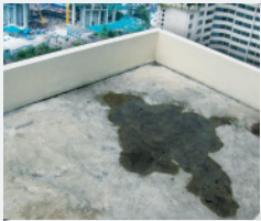
ดาดฟ้าคอนกรีต Concrete Deck
